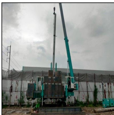
รูปที่ 33 การก่อสร้างฐานรากโดยใช้เสาเข็มกด
