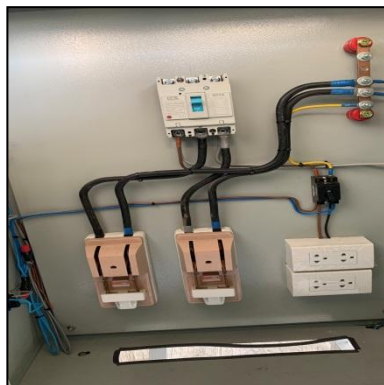
รูปที่ 54 เครื่องตัดกระแสไฟฟ้าอัตโนมัติ
