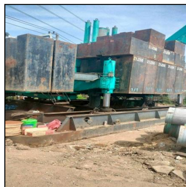
รูปที่ 33 การก่อสร้างฐานรากโดยใช้เสาเข็มกด
