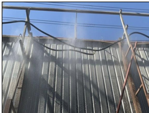
รูปที่ 21 ระบบสเปรย์น้ำภายในพื้นที่โครงการ
